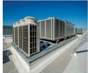
HỆ THỐNG ĐIỀU HÒA TRUNG TÂM LINH HOẠT (VRV)
